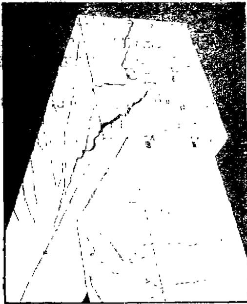
图18 柱顶劈裂裂缝向节点正面延伸
