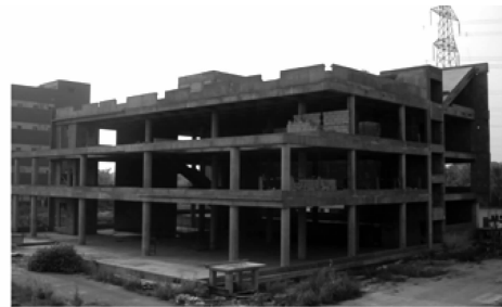
图 8 停工时的该建筑建设情况
