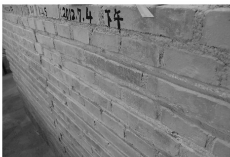
图 6 试验墙体图 Fig. 6 Test wall
